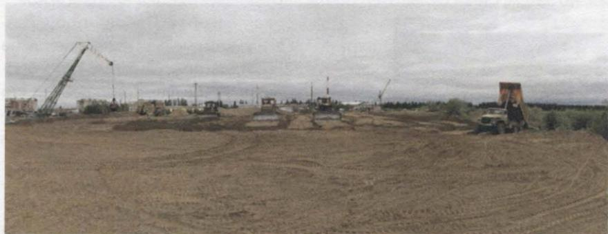
Поскольку вылет стрелы плавкрана не позволял накапливать грунт на гребне дамбы, грунт из баржи сначала выгружался на спланированную берму откоса, после чего до гребня дамбы перемещался бульдозером, который, постепенно снижаясь, по мере выработки грунта на берме, на конечном этапе перемещал грунт от уреза воды на 10-метровую
