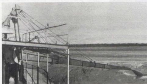
**Удлиненный лоток на земснаряде ПЧ-15.
