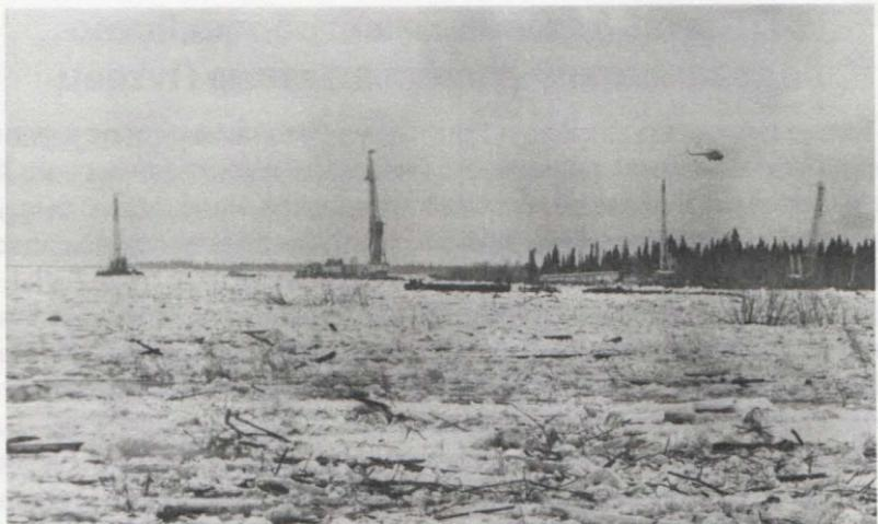
11 мая 1979 г. Флот техучастка и краны РЭБ Коминефть заторошены у правого берега реки ниже устья затона. Перед вторым слева краном счал земснарядов ПЧ-9, ПЧ-710, ПЧ-205, ПЧ-221. Вертолет доставил кислород и металл для заделки пробоины на ПЧ-205 и садится для съемки людей с аварийной брандвахты
