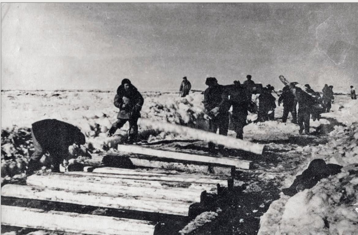
Укладка шпал на строительстве Северной-Печорской железной дороги.
